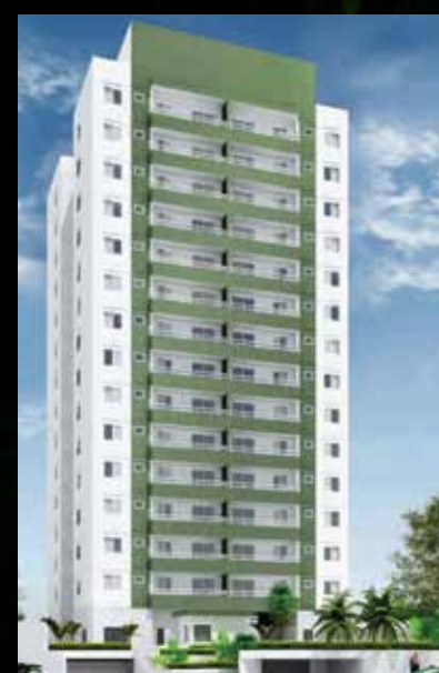
Edifício Buriti Vila Progresso São José dos Campos - SP
